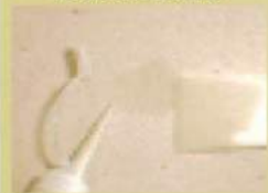
擦り傷などの部分補修
